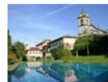
05 Casa dos Assentos Barcelos 1 D; 2 Tw; 3 Apx4; 1 Apx6; 2P; T
