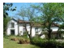
25 Casa do Outeiro Ponte de Lima 3 Tw P
